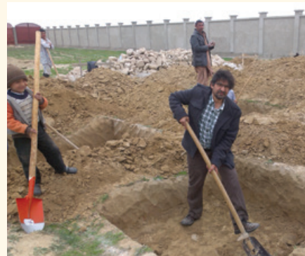
Začiatok výstavby v roku 2015
