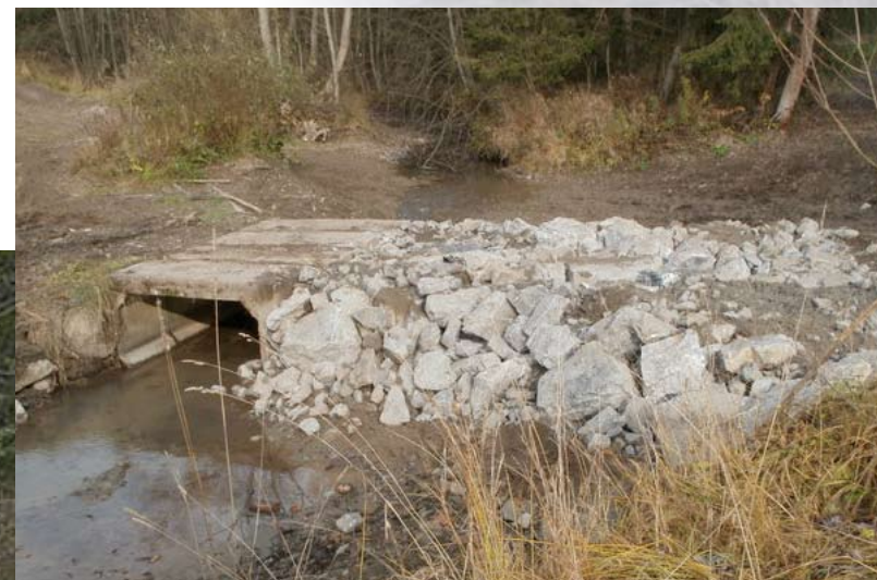
Kamenná sypaná hrádza
