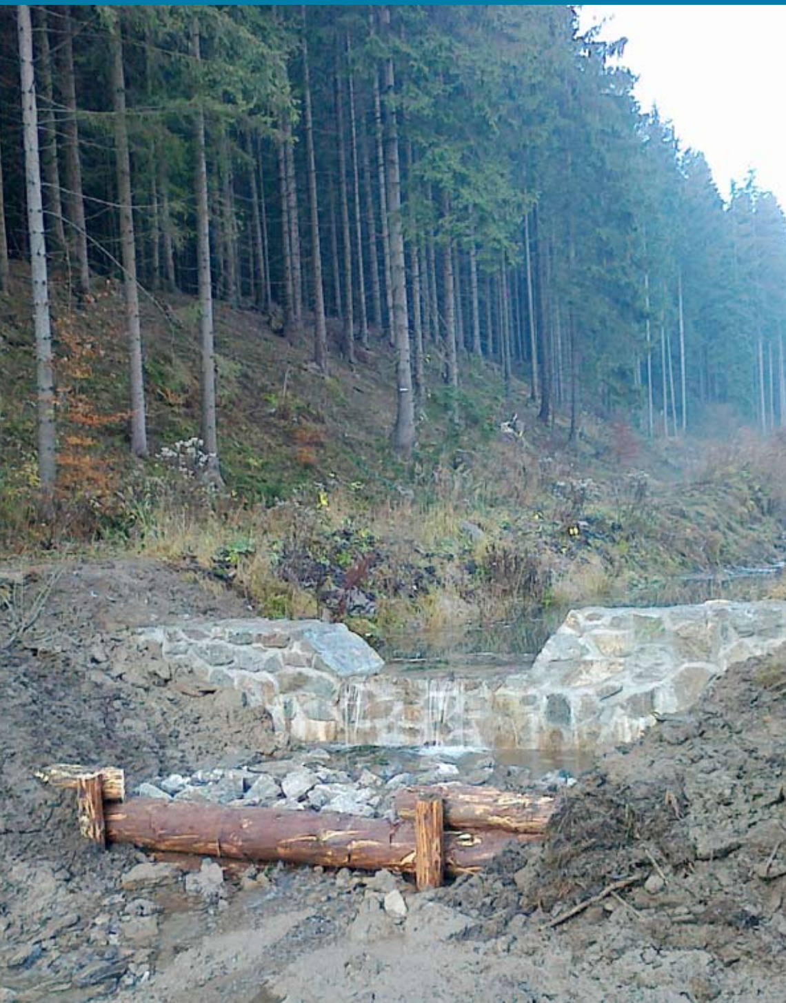
Sypaná kamenná hrádza s dimenzujúcim otvorom
