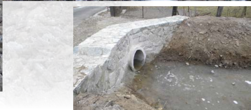
Murovaná prehrádzka z lomového kameňa
