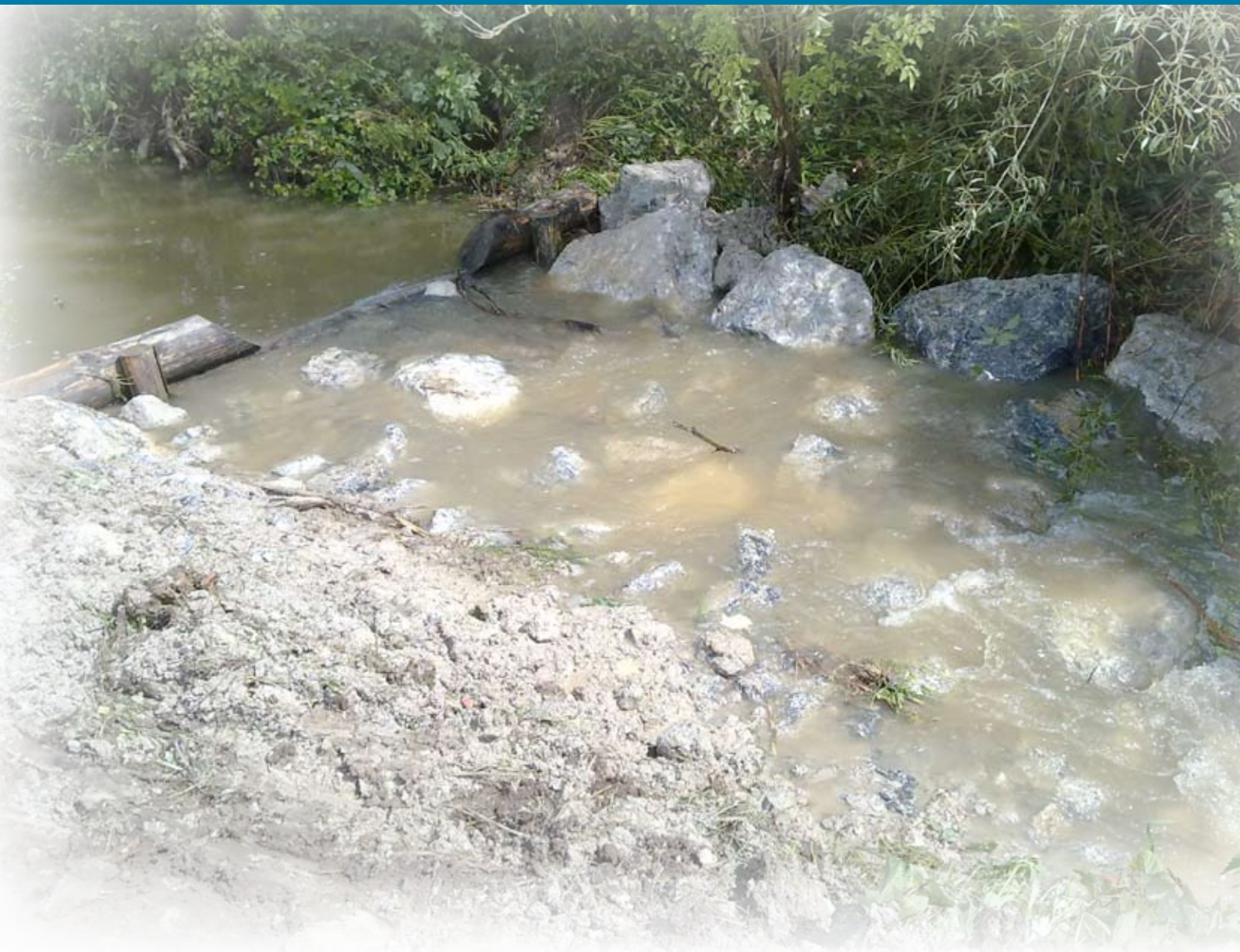
Zaistenie dreveného stupňa kameňovou rovnatinou
