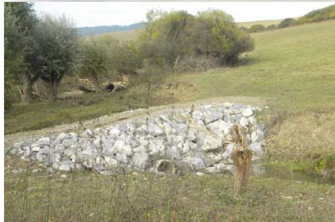
Sypaná kamenná hrádza s dimenzujúcim otvorom
