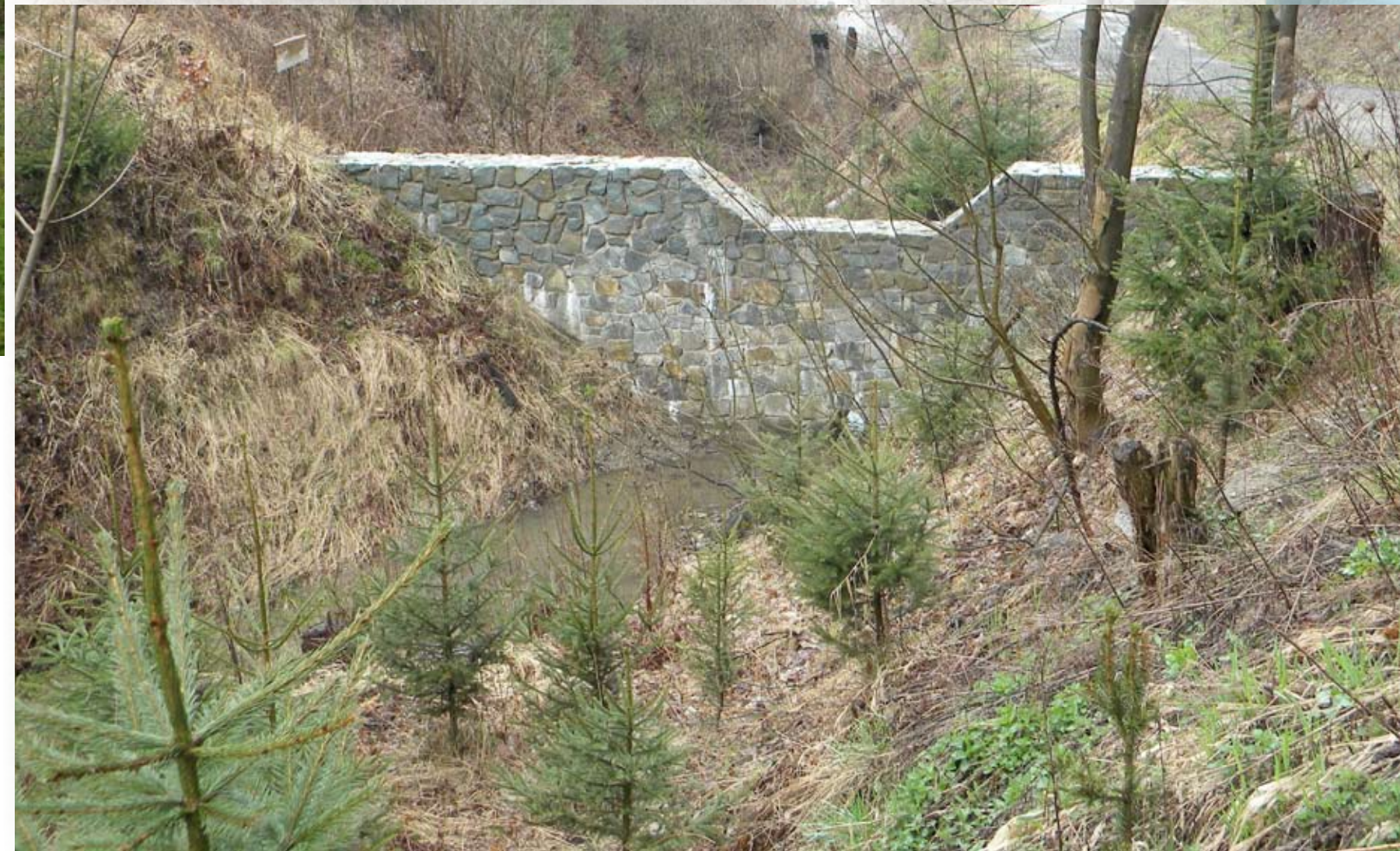
Murovaná prehrádzka z lomového kameňa
