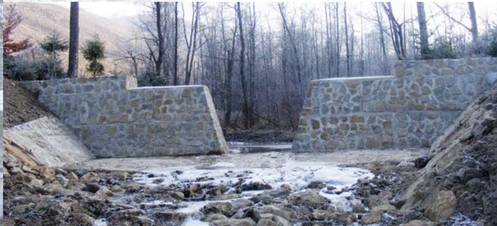
Murovaná prehrádzka z lomového kameňa
